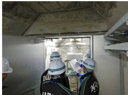
【監査廊の観測機器で点検】
