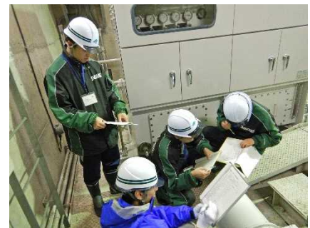
【ゲート室の点検】
