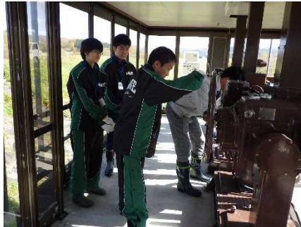
【樋門操作を体験】
