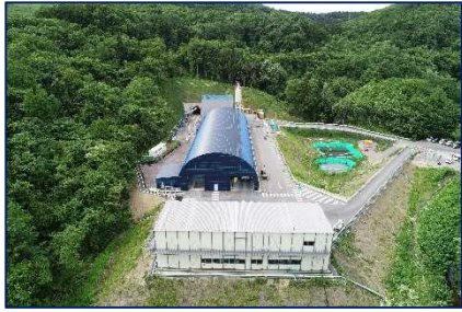
【大沼トンネル避難坑峠下工区工事】
