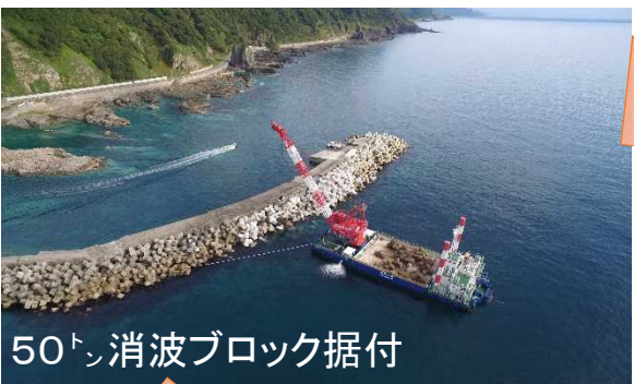
50トンの消波ブロックの運搬(瀬棚港→須築漁港)
