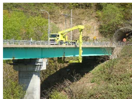
橋梁点検車による橋梁点検状況
