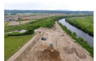
河道掘削状況
