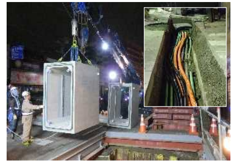
電線共同溝の管路設置状況
