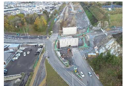
函館新外環状道路 空港道路の整備状況
