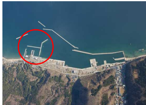
小型船だまりの整備が進む奥尻港
