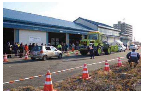
除雪車による牽引状況
