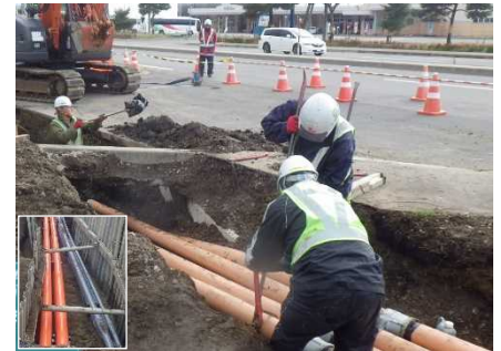
電線共同溝の管路設置状況
