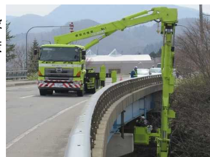
橋梁点検車による橋梁点検状況
