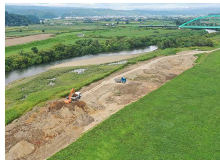
河道掘削状況
