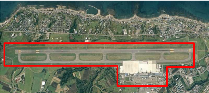
函館空港 排水対策整備箇所
