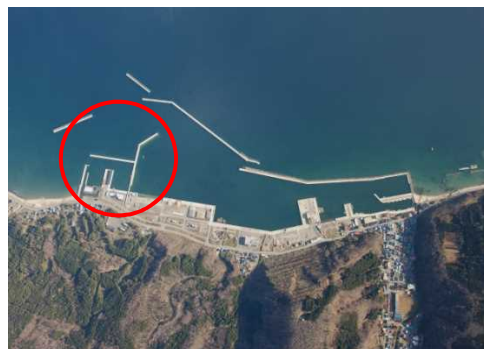
小型船だまりの整備が進む奥尻港
