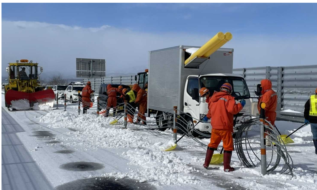
<除雪作業状況>
