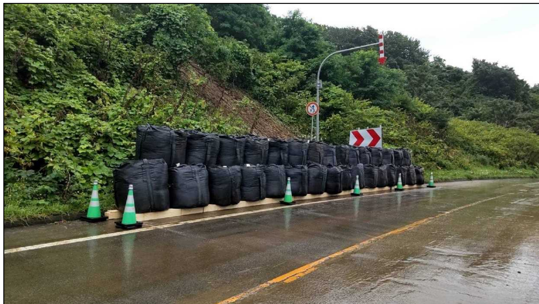
<国道228号上ノ国町汐吹の土砂撤去及び土のう設置状況>
