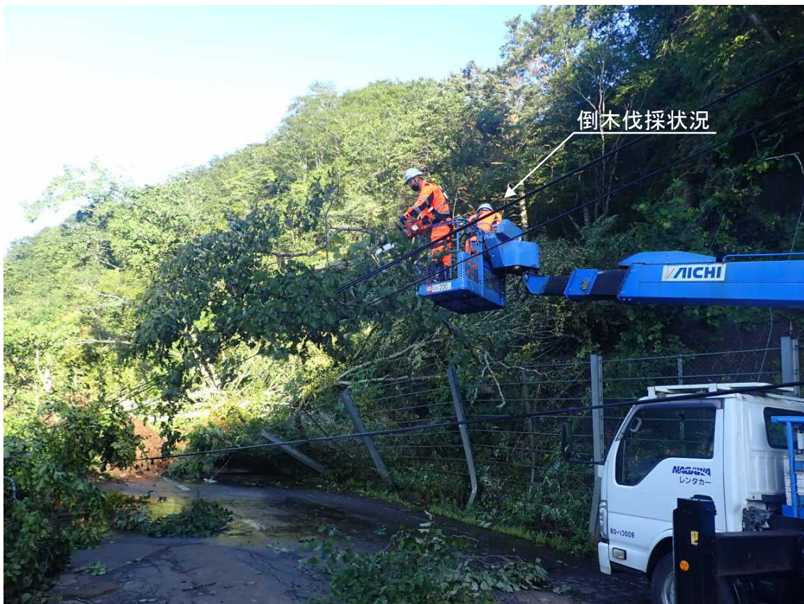
<復旧に向けた作業状況>
