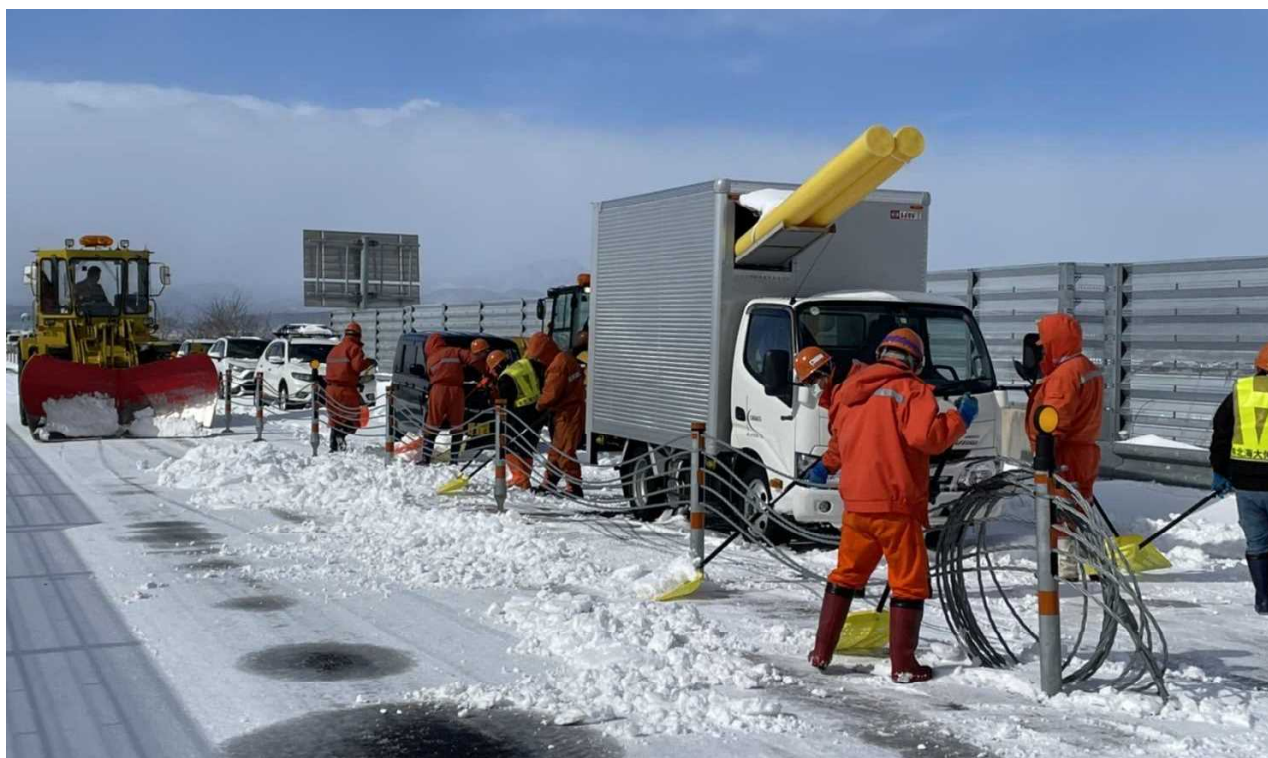
<除雪作業状況>
