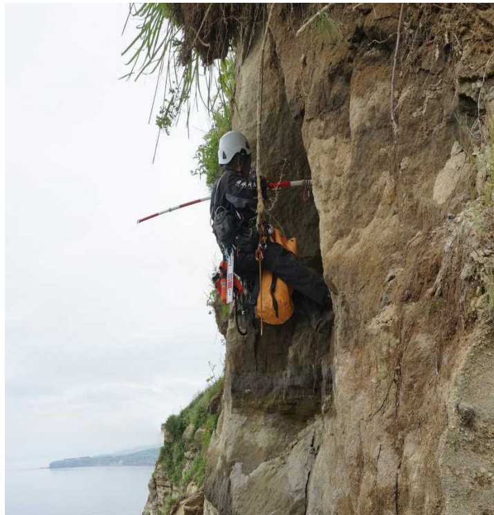
<高所法面点検者による近接目視の様子(近景)>
