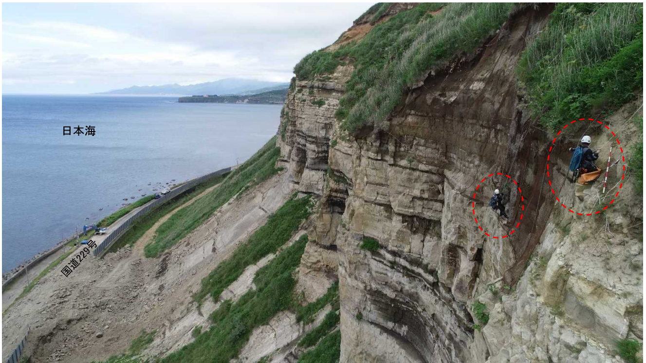
<高所法面点検者による近接目視の様子(全景)>
