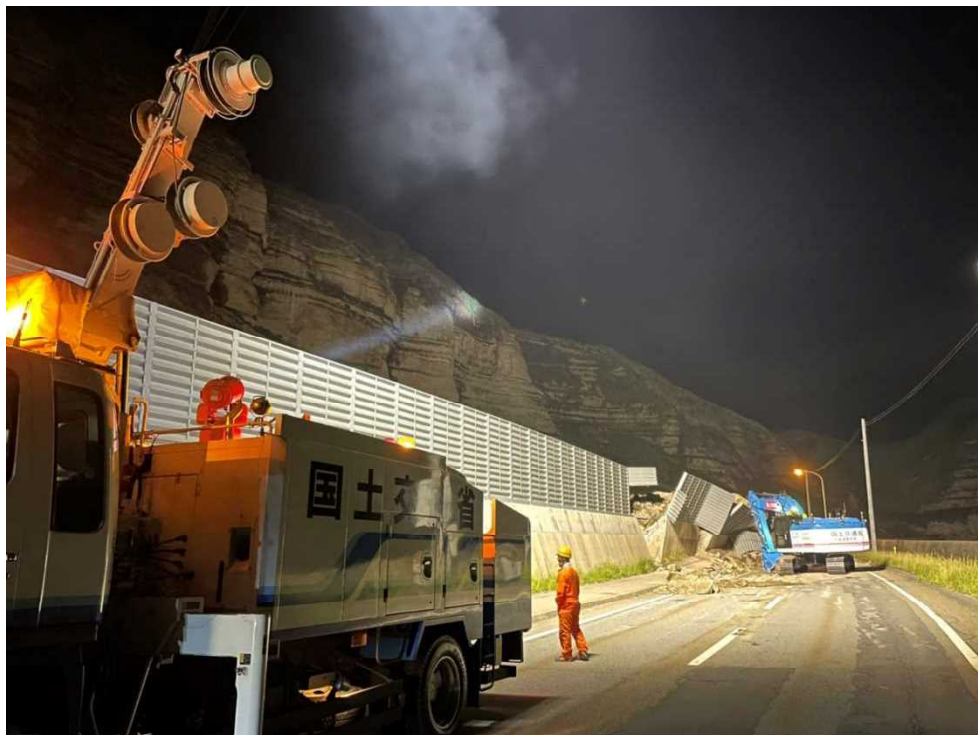
＜無人バックホウによる作業状況②＞
