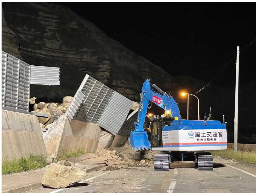
＜無人バックホウによる作業状況①＞
