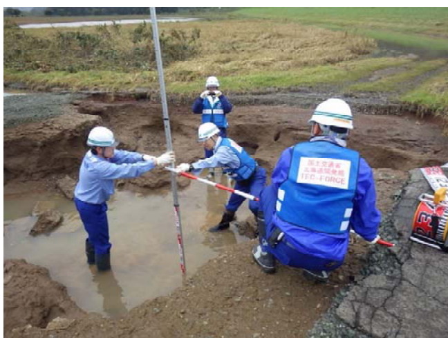
北見市常呂被災状況調査
