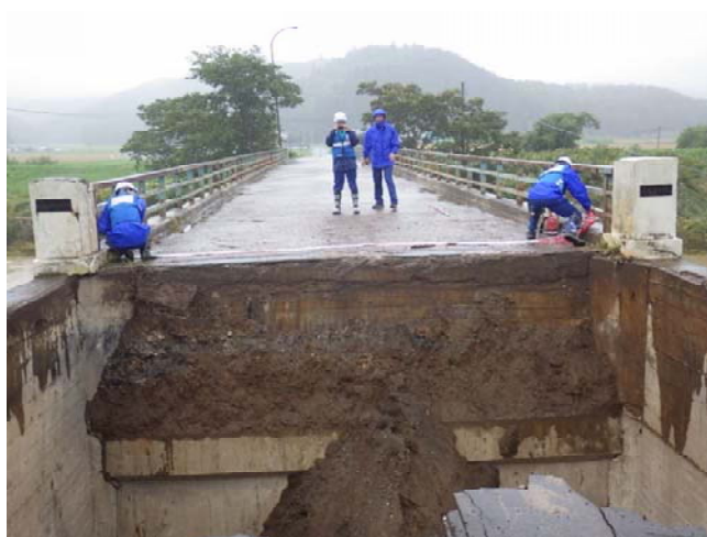
北見市常呂被災状況調査
