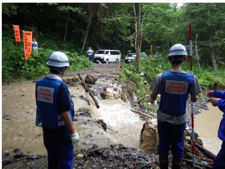
村道二ニウ1号線被災調査状況
