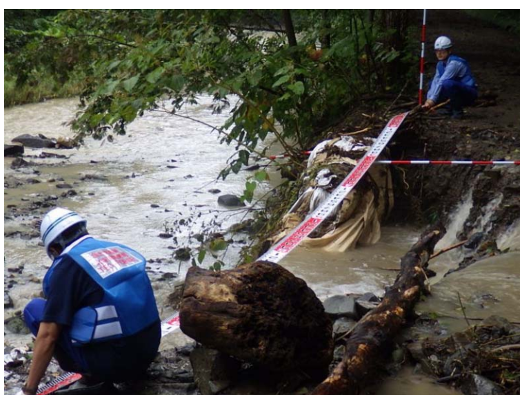
村道二ニウ1号線被災調査状況
