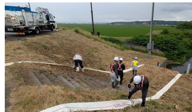
災害対策用機械出動等に関する協定に基づき実施した 排水ポンプ車搭載の水中ポンプ設置・撤去訓練（今金町）
