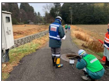
【農業集落排水施設の調査】
