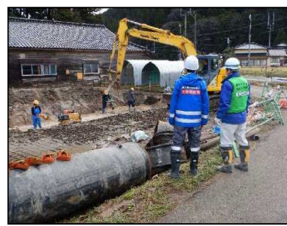
【復旧工事の状況】
