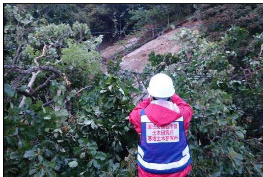
【国道付近地すべりの現地状況】
