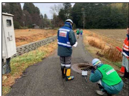
【農業集落排水施設の調査】
