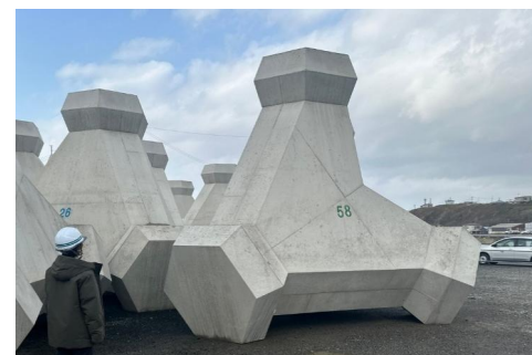
マッセルコンクリートブロック製作・据付
