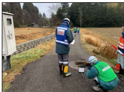
【農業集落排水施設の調査】
