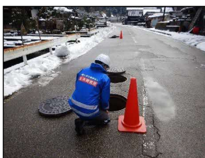
【被災施設の調査】
