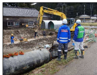
【復旧工事の状況】
