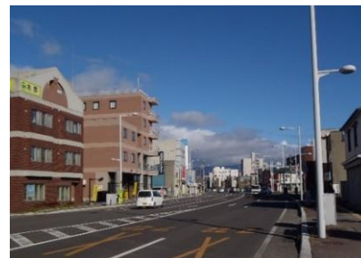
函館若松電線共同溝
