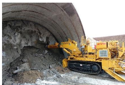
国道229号 乙部防災
