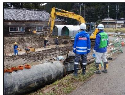
【復旧工事の状況】
