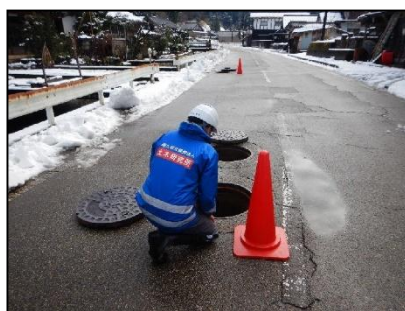
【被災施設の調査】
