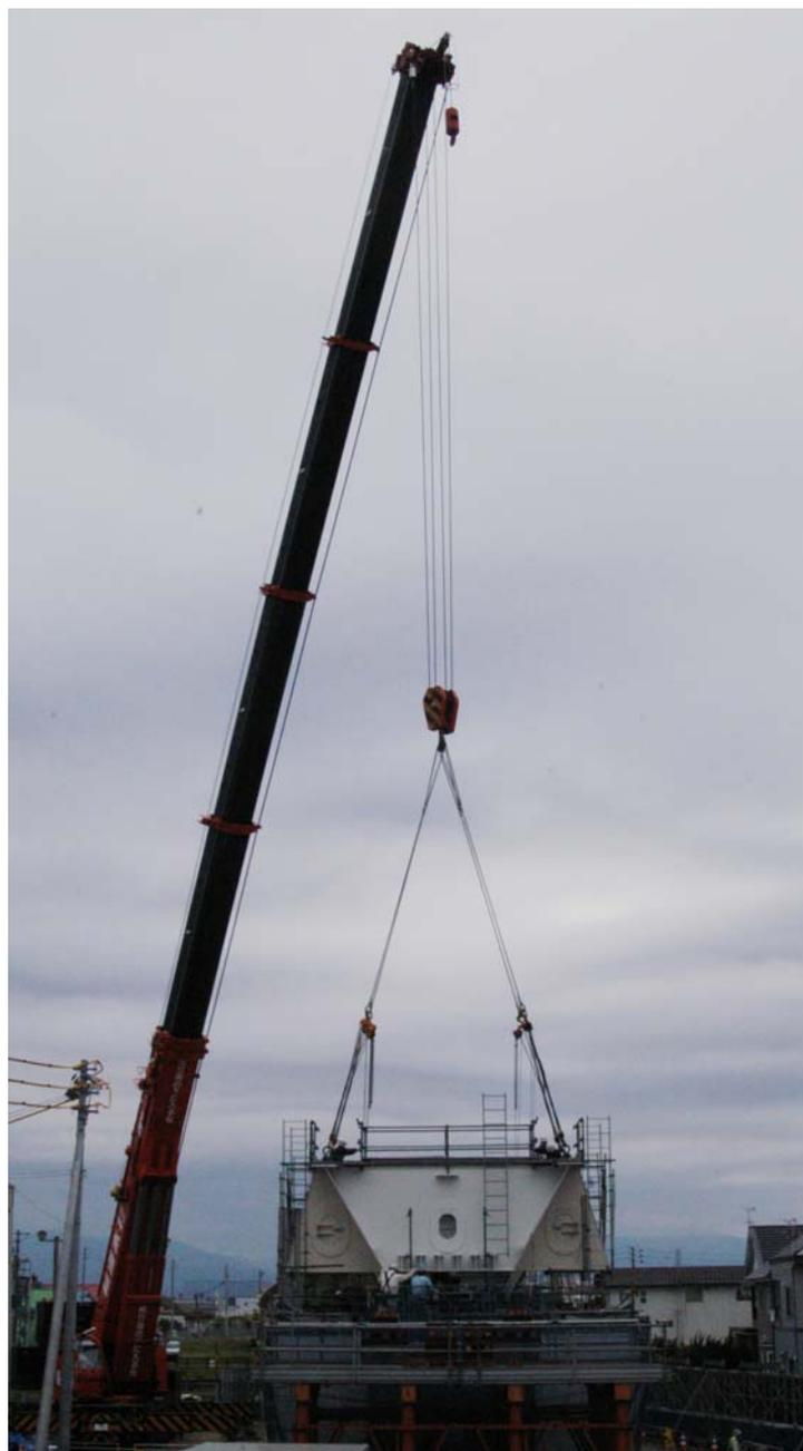
クレーンによる橋桁の吊り上げの様子
