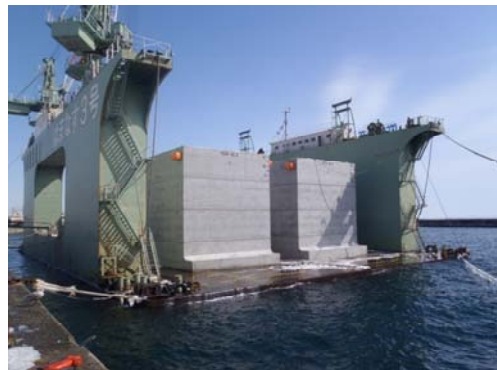
FDによるケーソン製作（同時製作4函）
