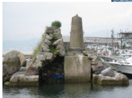
修復前(北側先端部)
