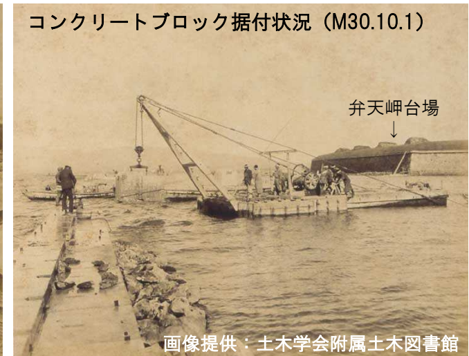
コンクリートブロック積み出し状況 (M30.10.1)
