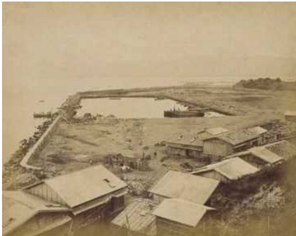
船入澗周辺埋立完了（明治31年7月4日） 周辺の埋立が完了して、健在の船入澗の姿とほぼ同じ状況が見て取れる。
