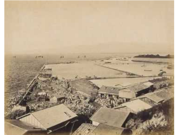
船入澗防波堤概整（明治30年10月1日） 防波堤と船入澗の護岸がほぼ完成。この後、埋立工事に着手。台場の石垣が小さくなっている。
