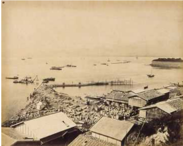
船入澗工事着手頃（明治30年7月1日） 山背泊から着手した船入澗防波堤、右奥に弁天岬台場が見える。
