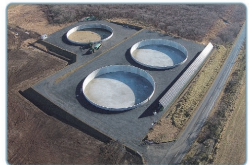
完成した肥培かんがい施設(根室地区)
