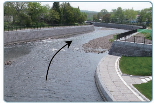
まちづくりと一体となった河川整備 (弟子屈地区の河道掘削)
