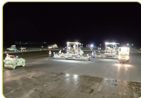
釧路空港滑走路改良状況
