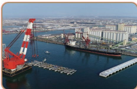
釧路港西港区国際物流ターミナル整備状況
