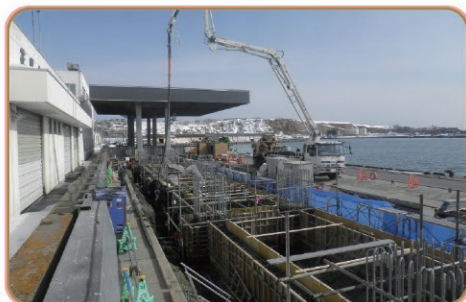
根室港花咲地区岸壁改良状況
