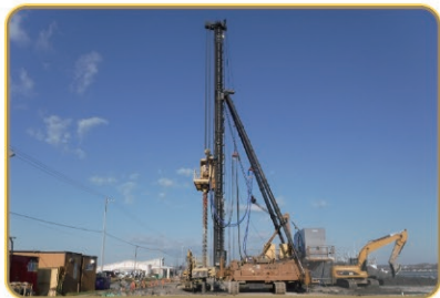
厚岸地区 係留施設整備状況
