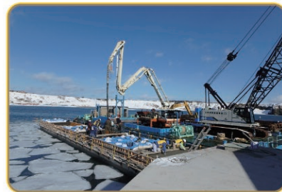
落石地区 外郭施設整備状況
