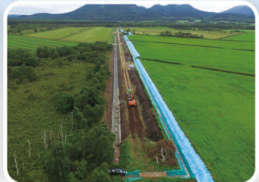
排水路整備状況（美留和地区）
