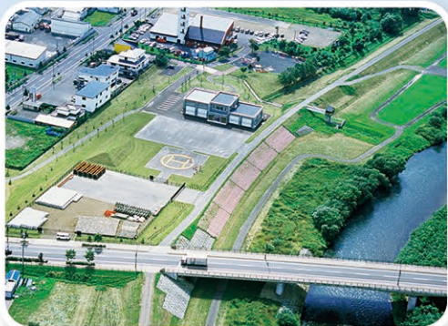
釧路川と標茶地区河川防災ステーション
