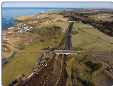
国道44号 根室道路
