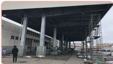
根室港花咲地区屋根付き岸壁整備状況
