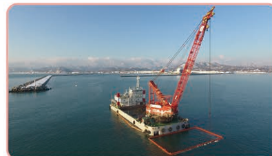
十勝港本港地区航路浚渫状況
