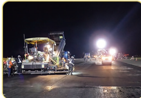
釧路空港滑走路改良状況
