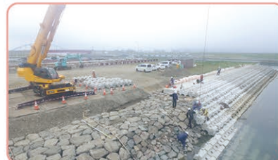
霧多布港本港地区用地護岸整備状況
