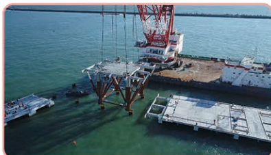
釧路港西港地区国際物流ターミナル整備状況
