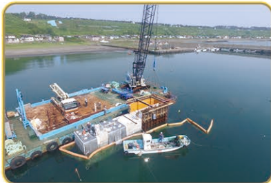
落石地区 外郭施設整備状況
