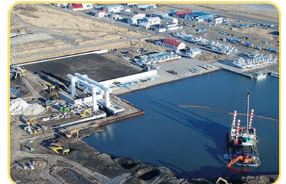
大津地区 漁港施設用地整備状況
