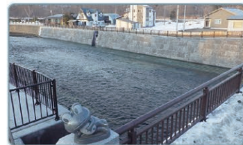
釧路川の河川改修状況 (弟子屈地区)
