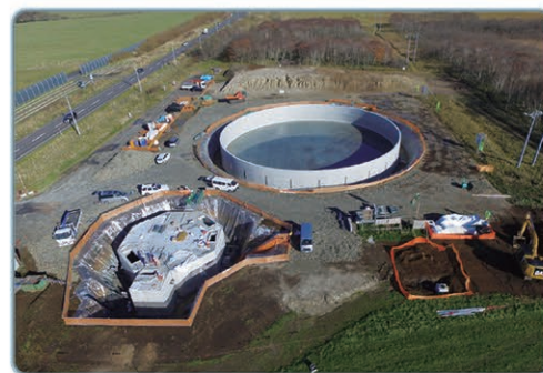
肥培かんがい流入口・配水調整池整備状況 (根室地区)
