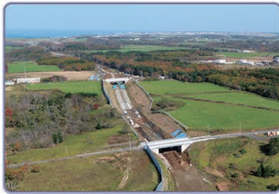
国道44号 根室道路
