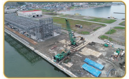
厚岸地区 係留施設整備状況
