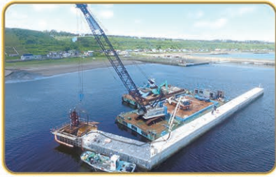
落石地区 外郭施設整備状況
