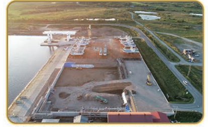
大津地区 漁港施設用地整備状況
