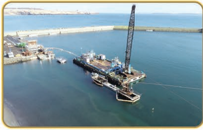
落石地区 係留施設整備状況
