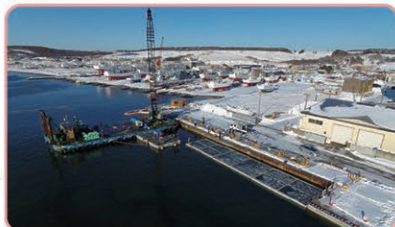
根室港花咲地区-6m岸壁整備状況
