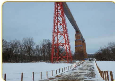
釧路空港進入灯橋梁改良状況
