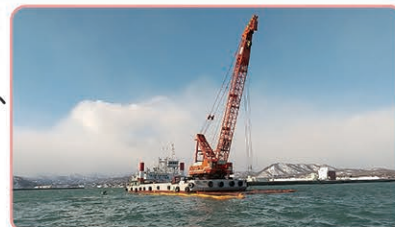
十勝港本港地区浚渫状況
