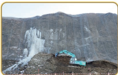
崩落土砂撤去(無人化)施工状況
