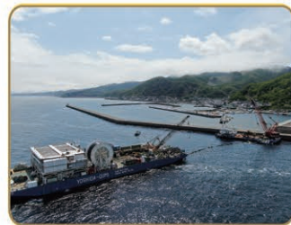
取水管敷設状況
