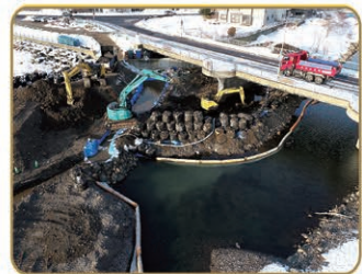
橋梁補修状況
