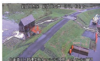
令和6年 大雨による排水ポンプ車の排水支援(標茶町)
