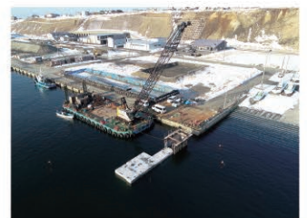
岸壁整備状況
