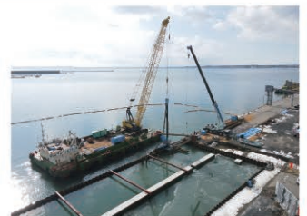
岸壁高上げ整備状況
