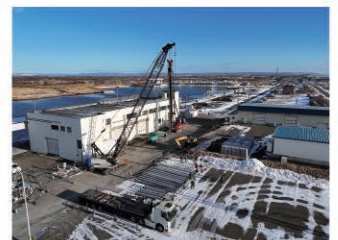
道路(屋根)整備状況
