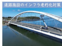
道路施設のインフラ老朽化対策 国道44号 温根沼大橋(根室市)
