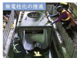
無電柱化の推進 国道38号 釧路橋北地区 電線共同溝
