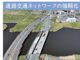
道路交通ネットワークの強靱化 国道44号 雪裡橋架替
