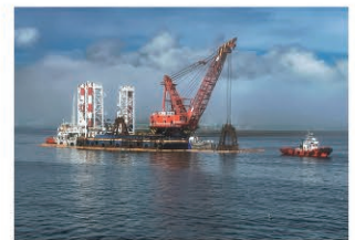
十勝港本港地区 航路浚渫状況
