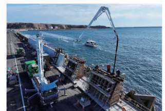
根室港花咲港区 南防波護岸整備状況
