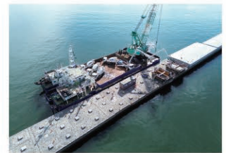
釧路港西港区 新西防波堤 上部コンクリート打設状況
