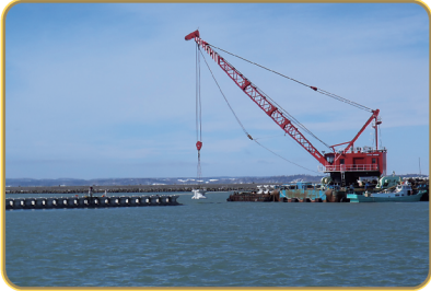
厚岸地区波除堤整備状況
