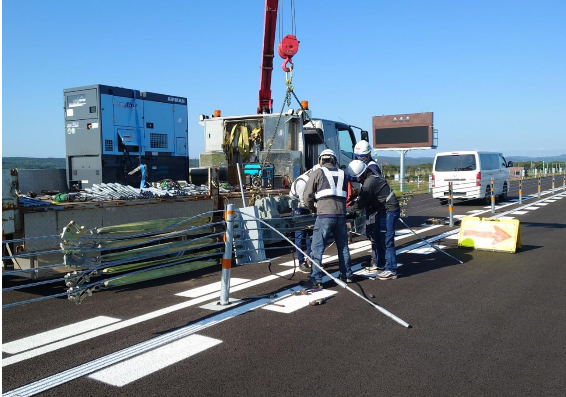
防護柵工（ワイヤーロープ）
