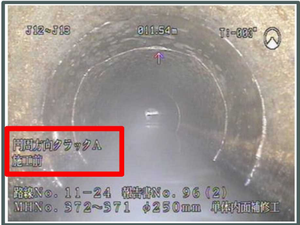
TVカメラによる管内の詳細調査
