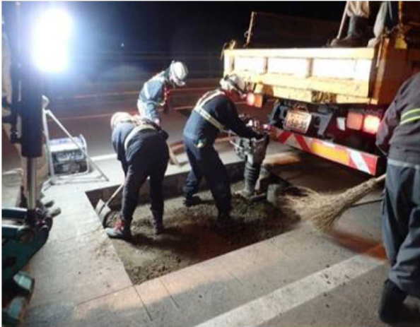
補修状況：国道12号（北海道札幌市）
