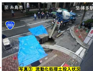
写真③ 流動化処理土投入状況
