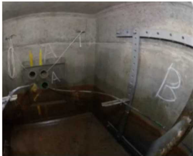
マンホール内写真
