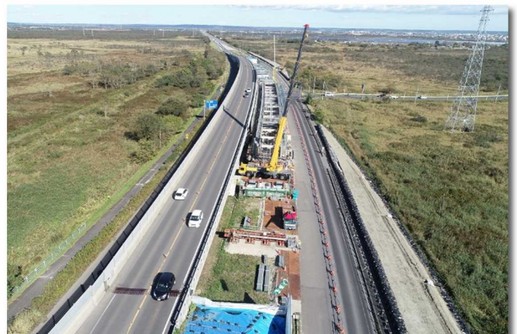
【施工状況(星が浦北通高架橋)】
