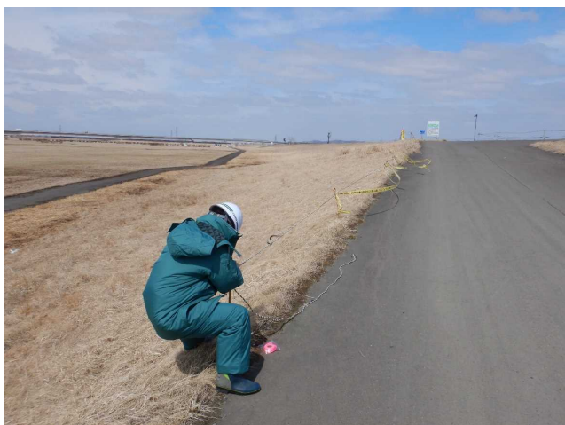
転落防止ネット留め具はずれ
