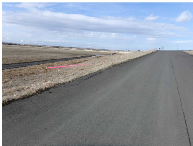
転落防止ネット修復
