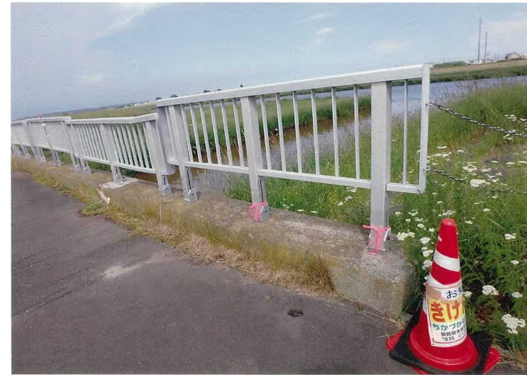
注意喚起テープ設置(補修予定)
