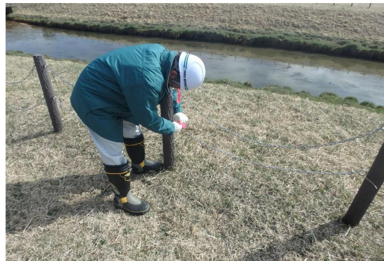
応急処置・注意喚起テープ設置
