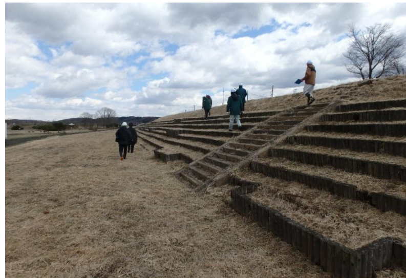
点検実施状況
