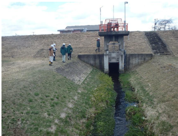
点検実施状況
